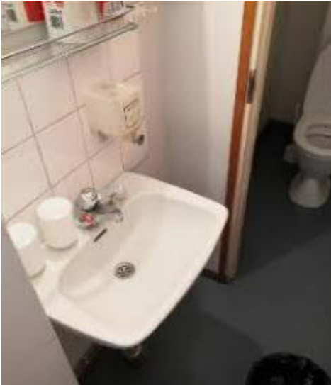
Kuva 4. WC-tilassa vanha Oraksen yksiotehana sekä pesuallas, taustalla uusittu WC-istuin.
